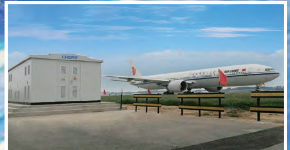
北京首都国际机场飞行区机位电力改造项目
