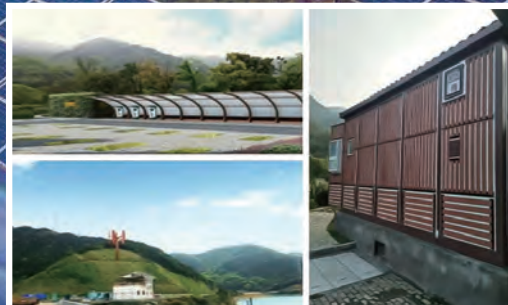
舟山智能台区风、光、储、充一体化项目
