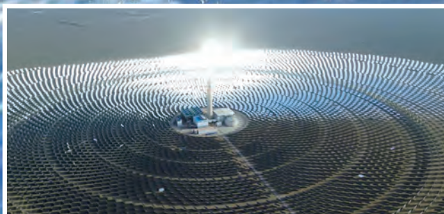
敦煌100MW光热发电项目
