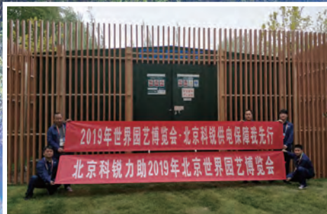
2019年世园会园区基础设施建设项目
